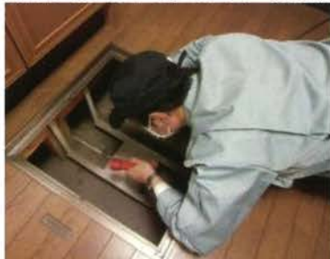
「土台・床組、基礎」調査の様子
