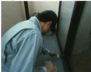
「外部（バルコニー）」調査の様子
