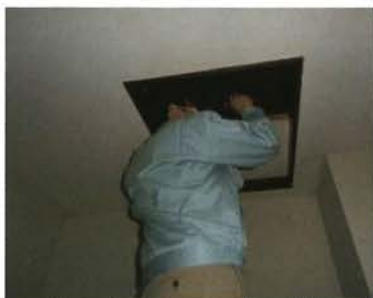
「小屋組・梁」調査の様子
