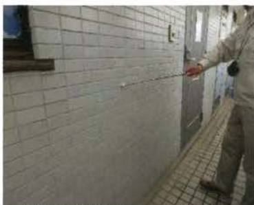
「外部（外壁）」調査の様子
