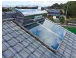
太陽熱温水器設置工事
