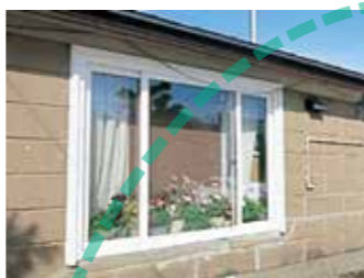
断熱サッシ(ガラス)への改修
