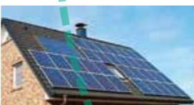
太陽熱発電システム設置工事
