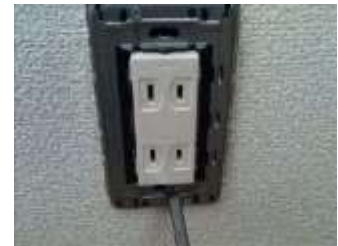
コンセントプレートをはずすと仕上げ材料の湿り具合などがわかる。
